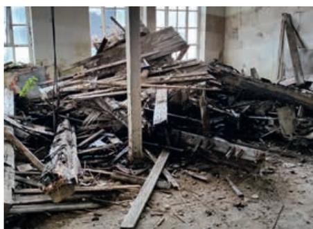
Am Roten Turm 1 haben die Sicherungsarbeiten für die ehemalige Baldauffabrik begonnen. Zurzeit wird das Gebäude von jahrzehntealtem Schutt befreit und entkernt. Die umfangreichen Straßensperrungen
