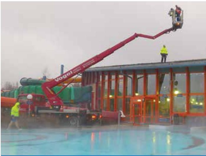
Untersuchung des Foliendaches der Haupthalle mittels Thermografie von einer Arbeitsbühne aus.
