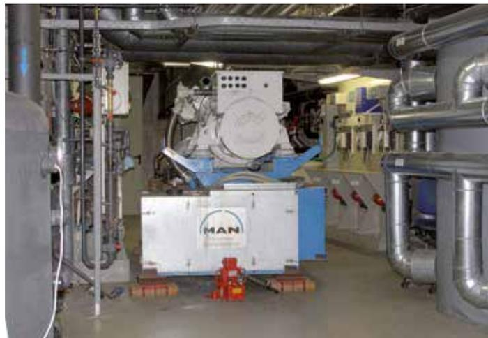
Transport eines Blockheizkraftwerkes in der Technikebene
