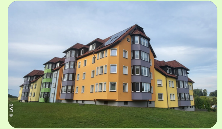
▲ Energetische Sanierung LWB
